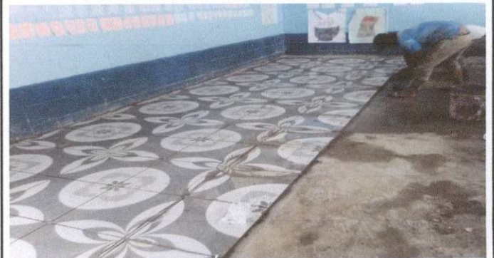
FOTO 2: SUSTITUCION DE PISO DE CONCRETO
