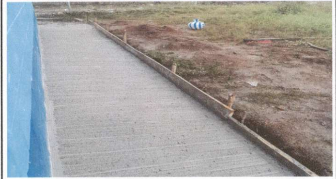
FOTO 4: SUSTITUCION DE BANQUETA
