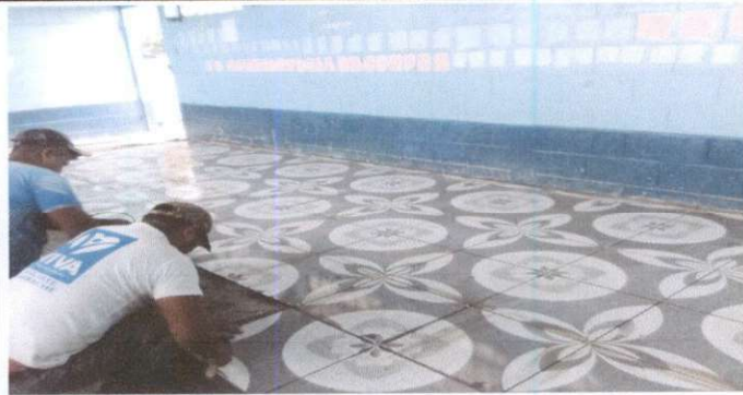
FOTO 1: SUSTITUCION DE PISO DE CONCRETO
