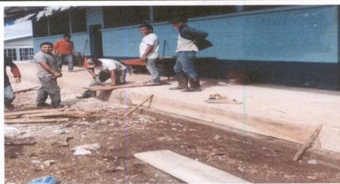
FOTO 3: SUSTITUCION DE BANQUETA
