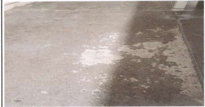
FOTO 2: SUSTITUCION DE PISO DE CONCRETO
