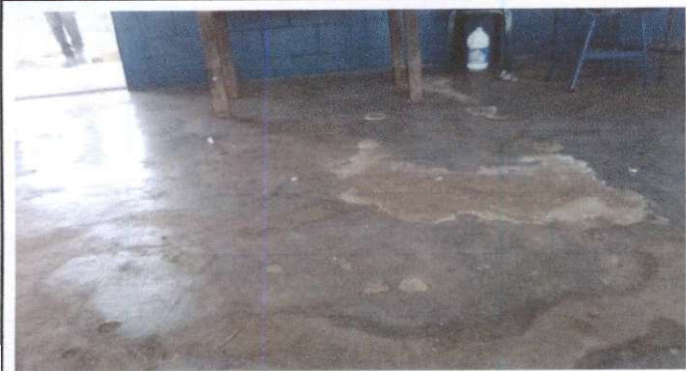
FOTO 1: SUSTITUCION DE PISO DE CONCRETO
