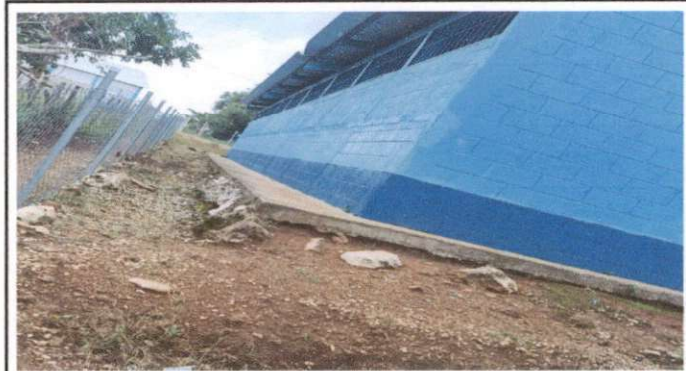
FOTO 4: SUSTITUCION DE BANQUETA
