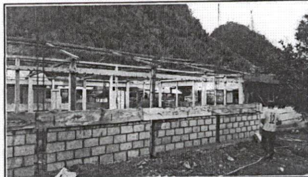
Foto 4: DESMONTAJE DE PAREDES
