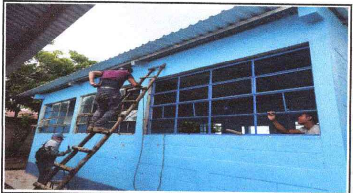
FOTO 4: SUSTITUCIÓN DE VIDRIOS, SUSTITUCIÓN DE BALCONES DE METAL
