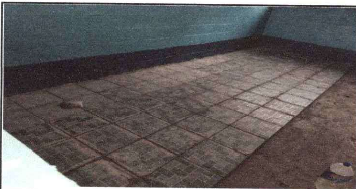
FOTO 5: SUSTITUCIÓN DE PISO CERÁMICO
