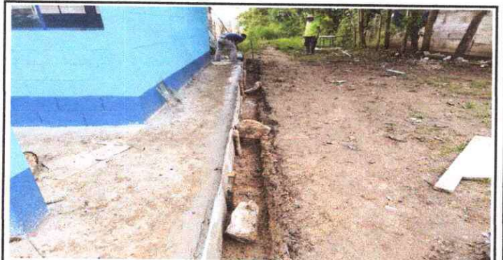
FOTO 6: REPARACIÓN DE CUNETETA DE CONCRETO
