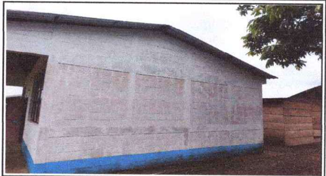
FOTO 8: PINTURA EN MUROS EXTERIORES E INTERIORES
