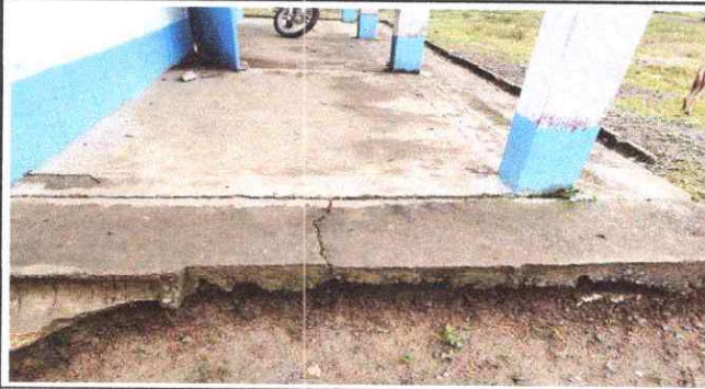
FOTO 7: REPARACIÓN DE BANQUETA DE CONCRETO
