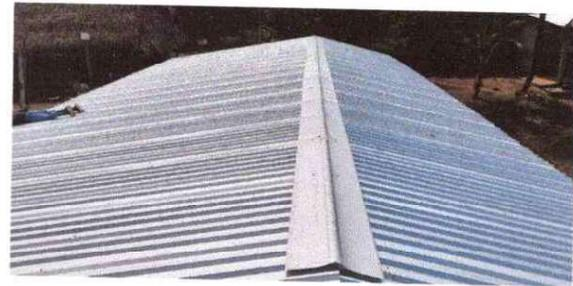
Foto 2: Sustitución de lamina, por lamina troquelada aluzinc calibre 26
