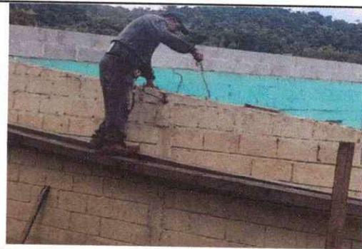
Foto 4: Sellado de grietas y fisuras en muro
