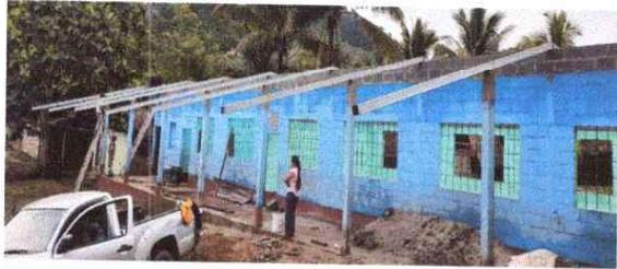
Foto1: Sustitución de estructura de soporte de madera, por metal.
