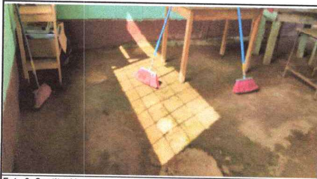
Foto 3: Sustitución de piso de torta en aulas
