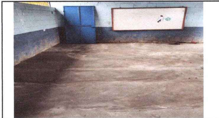
FOTO 3: Sustitucion de piso de torta de concreto
