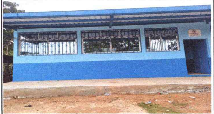
FOTO 2: Mantenimiento de estructura de metal de ventana
