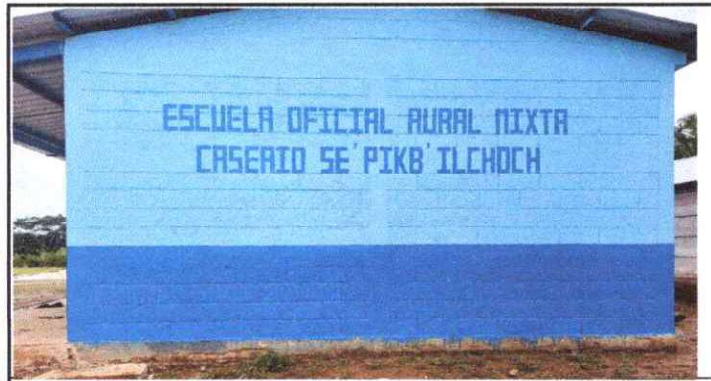
FOTO 5: Pintura en muros interiores y exteriores
