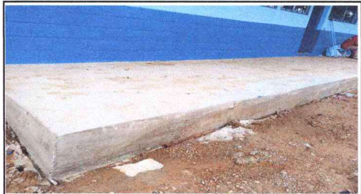
FOTO 4: Reparacion de planchas de concreto de patio
