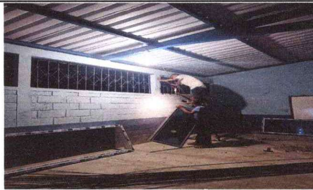
FOTO 2: Mantenimiento de estructura de metal de ventana
