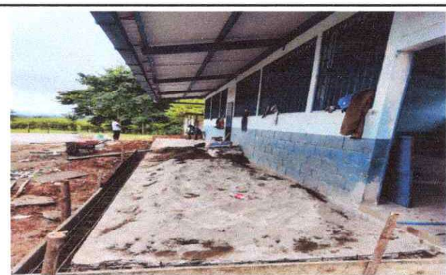
FOTO 4: Reparacion de planchas de concreto de patio
