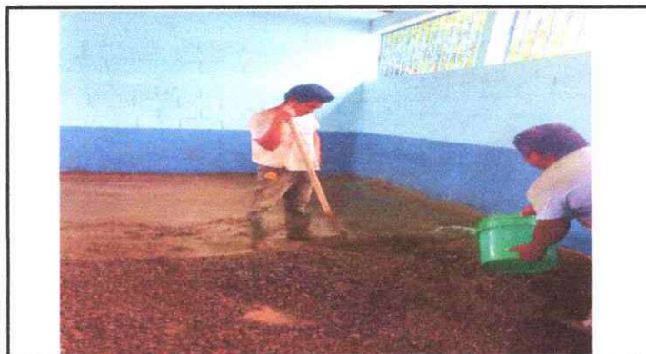
FOTO 3: Sustitucion de piso de torta de concreto
