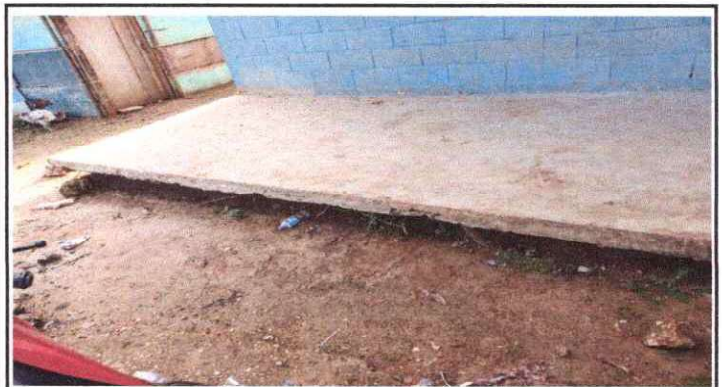
FOTO 4: Reparacion de planchas de concreto de patio
