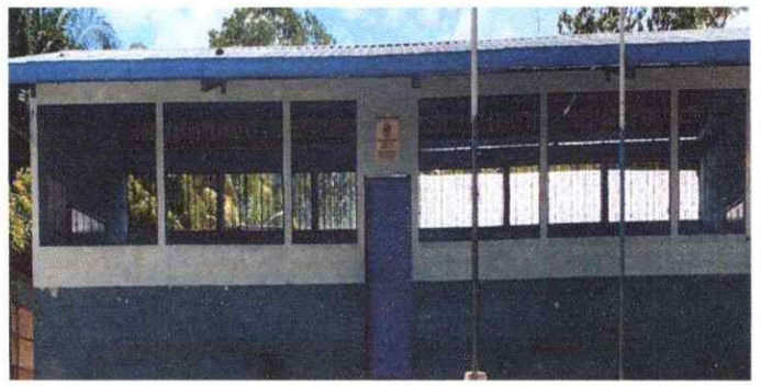
FOTO 2: Mantenimiento de estructura de metal de ventana
