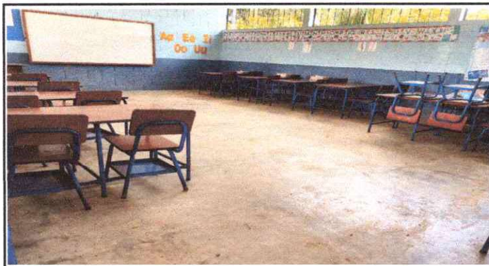
FOTO 3: Sustitucion de piso de torta de concreto
