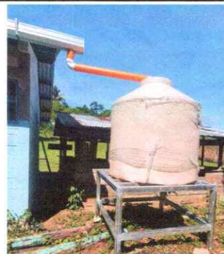
Foto 6: Sustitución de deposito de agua 1700 lt
