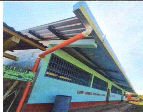
Foto 4: Sustitución de canal de metal
