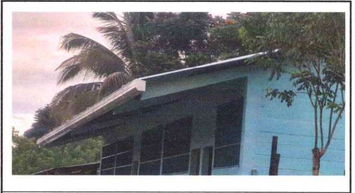
Foto 4: Sustitución de canal de metal
