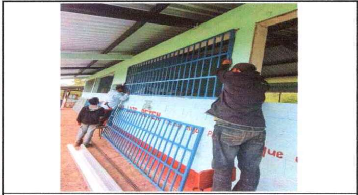
Foto 3: Fabricación e instalación de ventana-balcon de metal
