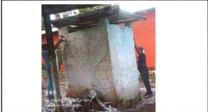
Foto 8: Repello en muro
