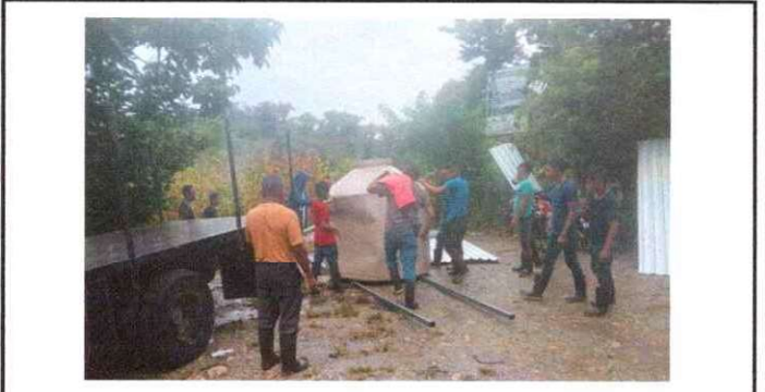
Foto 6: Sustitución de deposito de agua 1700 lt
