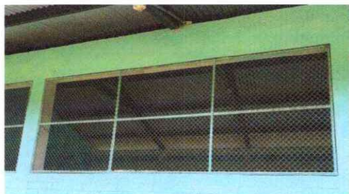
Foto 3: Fabricación e instalación de ventana-balcon de metal
