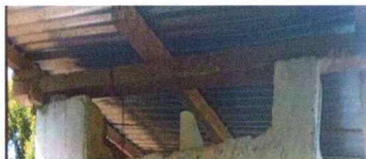
Foto 2: Sustitución de estructura de soporte de madera, por metal
