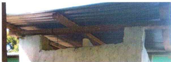
Foto1: Sustitución de lámina, por lámina troquelada aluzinc calibre 26
