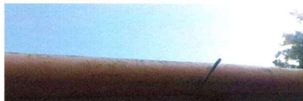
Foto 4: Sustitución de canal de metal
