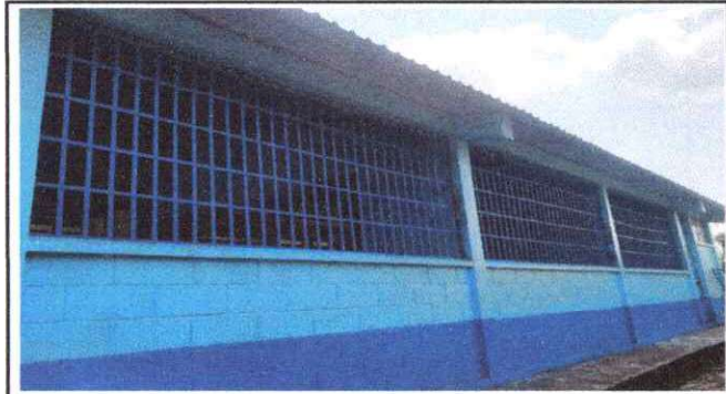
FOTO 4: SUSTITUCION DE VALCONES DE METAL
