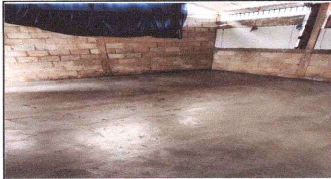
FOTO 1: REPARACION DE PISO DE TORTA DE CONCRETO
