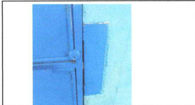
FOTO 3: SUSTITUCION DE CHAPAS
