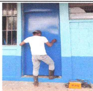
FOTO 2: SUSTITUCION DE PUERTA
