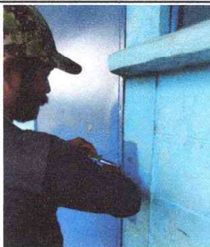
FOTO 3: SUSTITUCION DE CHAPAS
