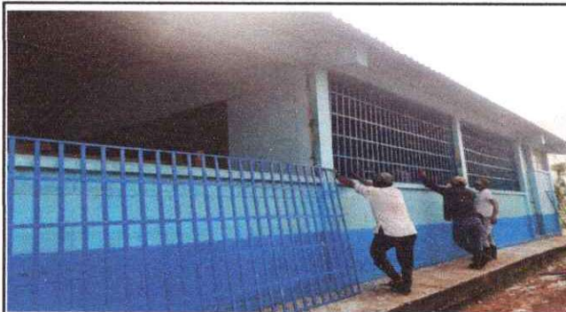
FOTO 4: SUSTITUCION DE VALCONES DE METAL
