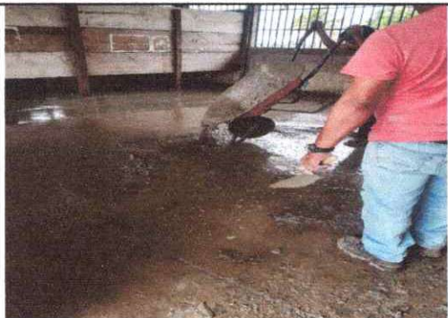
FOTO 1: REPARACION DE PISO DE TORTA DE CONCRETO
