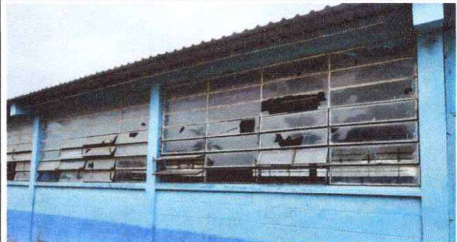
FOTO 4: SUSTITUCION DE VALCONES DE METAL
