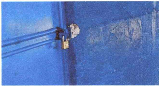
FOTO 3: SUSTITUCION DE CHAPAS
