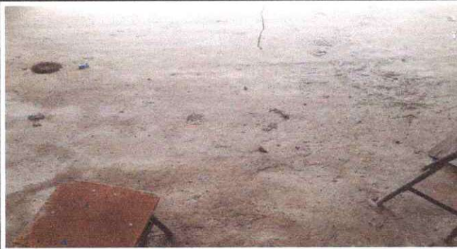
FOTO 1: REPARACION DE PISO DE TORTA DE CONCRETO
