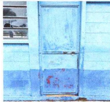
FOTO 2: SUSTITUCION DE PUERTA
