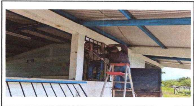
Foto 4: Sustitución de balcones en aulas
