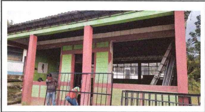
Foto 3: Sustitución de balcones en aulas
