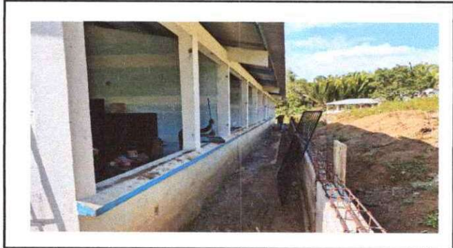
Foto 2: Sustitución de balcones en aulas
