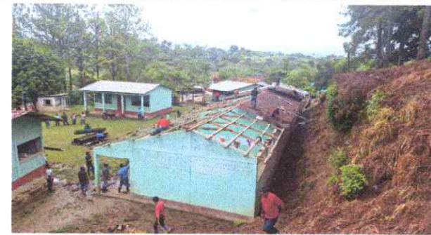
Foto 4: Sustitucion de capote de lámina para lámina troquelada aluzin calibre 26.
