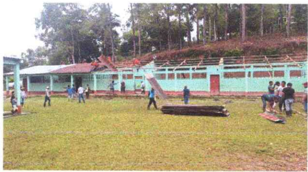
Foto 3: Sustitucion de lámina, por lámina troquelada aluzin, calibre 26.
