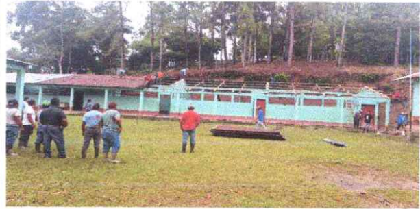
Foto2: Sustitución de lamina, por lámina troquelada aluzin calibre 26.
