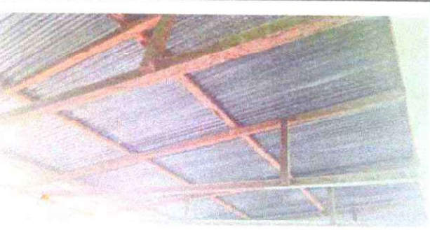
Foto 5: Sustitución de estructura de soporte de madera por metal.
