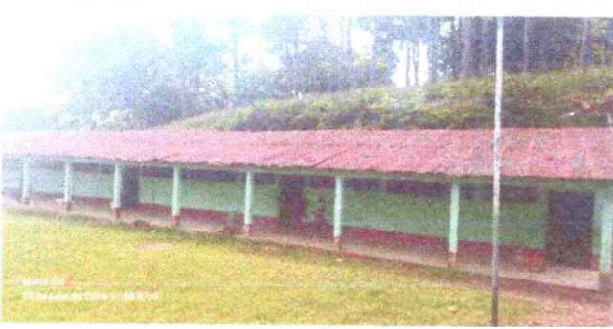
Foto 3: Sustitución de lámina, por lamina troquelada.
