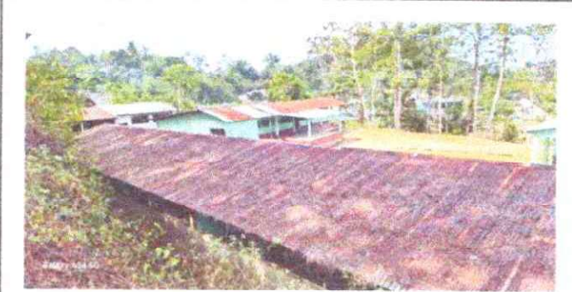
Foto 4: Sustitución de capote de lámina para lámina troquelada.
