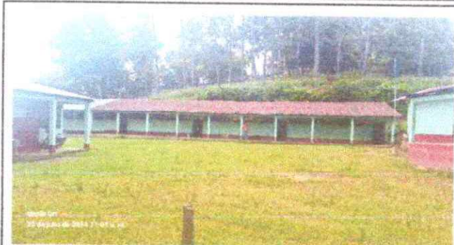
Foto 2: Sustitución de lámina, por lámina troquelada aluzin, calibre 26.
