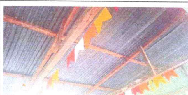
Foto 6: Sustitución de estructura de soporte de madera por metal
