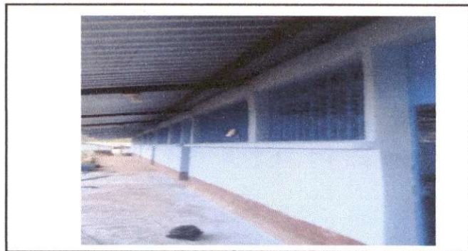
Foto 6: Pintura en muros interiores
