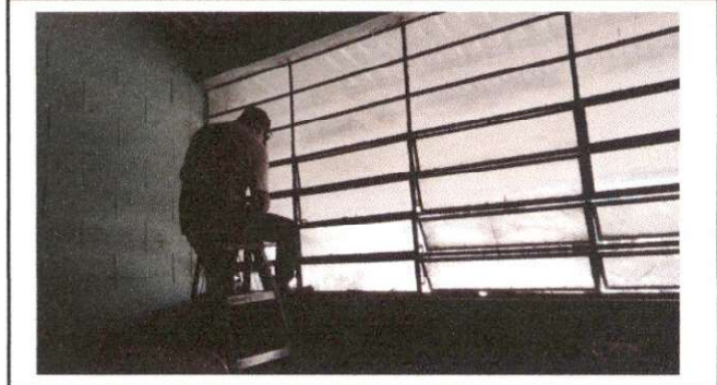
Foto 2: Sustitucion de balcones de metal.
