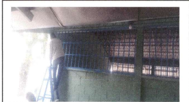
Foto 4: mantenimiento a balcones de metal.
