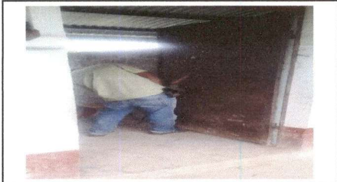
Foto 3: mantenimiento a estructura
