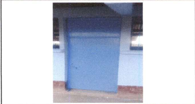
Foto1: Sustitución de puerta.
