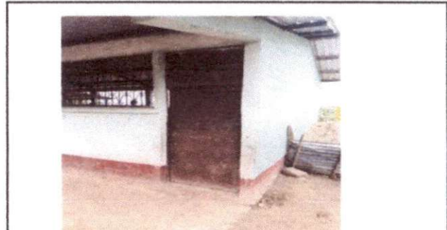
Foto 4: Reparación de banqueta de concreto
