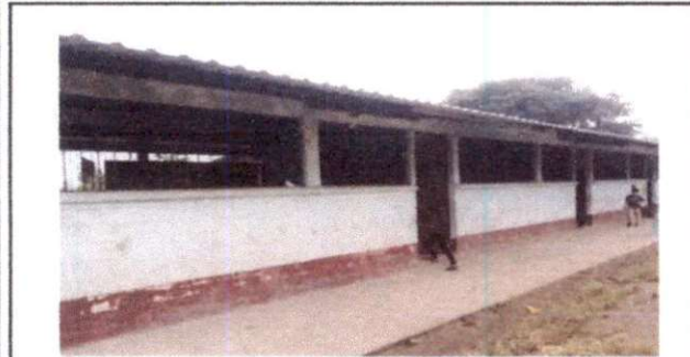
Foto 3: Reparación de banqueta de concreto
