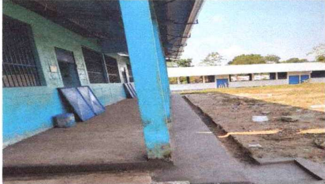
FOTO 1: REPARACION DE PLANCHAS DE CONCRETO DE PATIO
