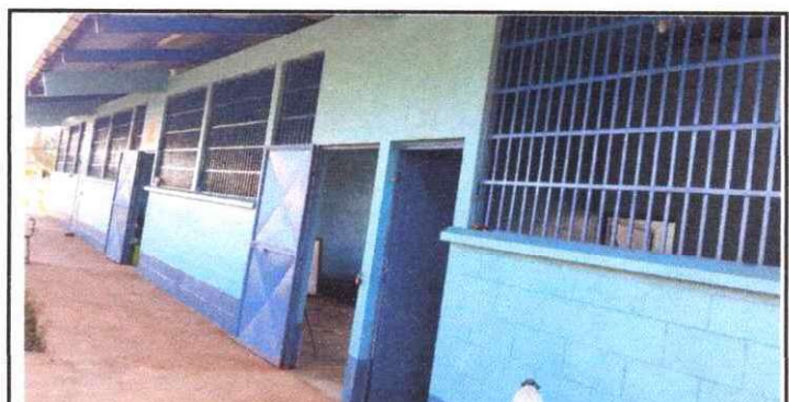
FOTO 6: SUSTITUCION DE BALCONES
