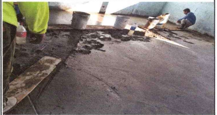
FOTO 2: SUSTITUCION DE PISO DE TORTA DE CONCRETO
