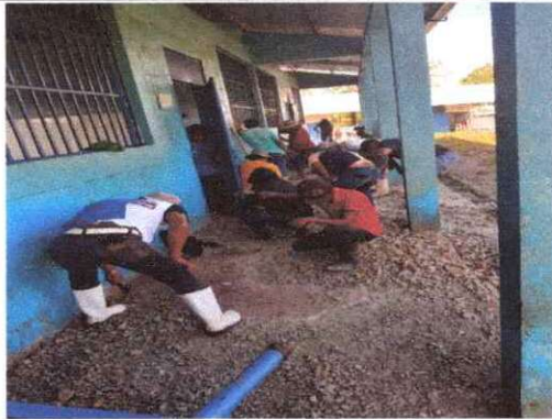
FOTO 1: REPARACION DE PLANCHAS DE CONCRETO DE PATIO
