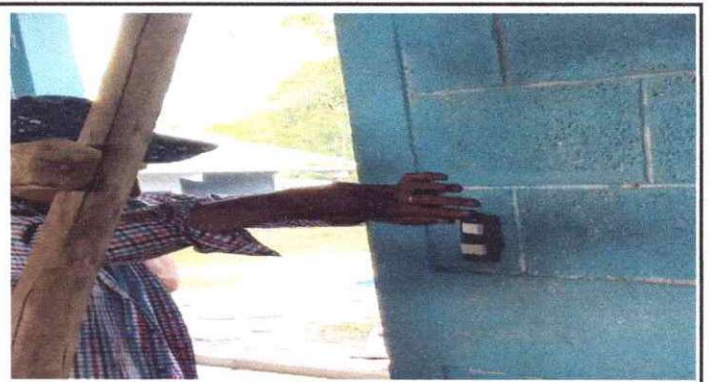
FOTO 4: SUSTITUCION DE INTERRUPTORES DOBLES
