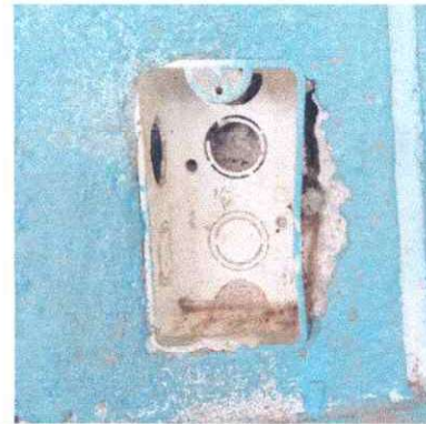
FOTO 4: SUSTITUCION DE INTERRUPTORES DOBLES
