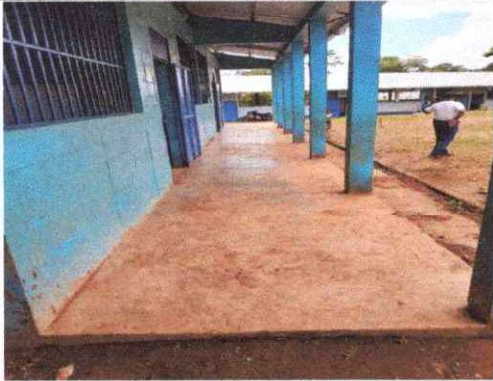
FOTO 1: REPARACION DE PLANCHAS DE CONCRETO DE PATIO
