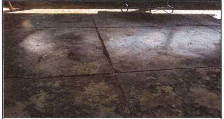
FOTO 2: SUSTITUCION DE PISO DE TORTA DE CONCRETO
