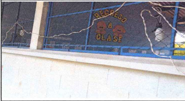
FOTO 7 REPARACION DE CABLEADO ELECTRICO
