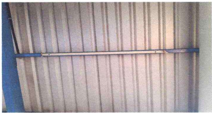
FOTO 3: SUSTITUCION DE LAMPARAS TIPO LED, SUSTITUCION DE PLAFONERAS
