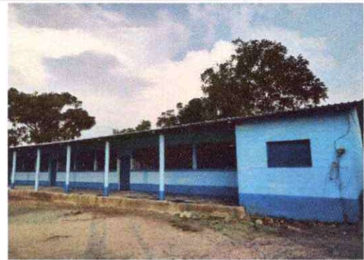
Foto 4: Pintura en muro exterior e interior.
