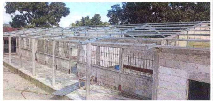
Foto 6: Cambio de estructura de soporte.
