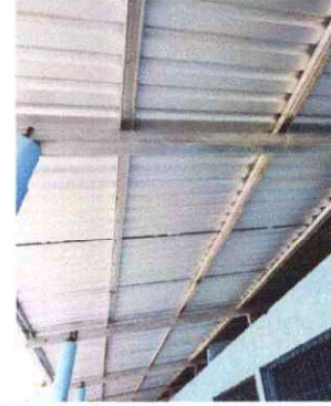
Foto 2: Cambio de estructura de soporte.
