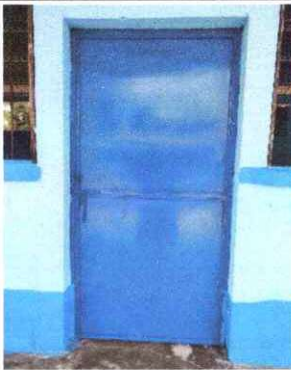
Foto 3: Cambio de puerta principal.
