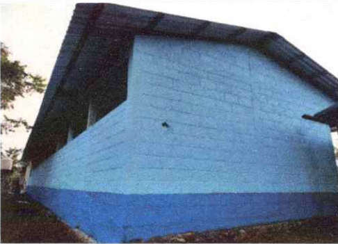
Foto 5: Cambio de estructura de techo.
