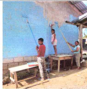
Foto 4: Pintura en muro exterior e interior.
