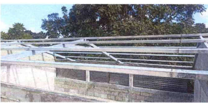
Foto 5: Cambio de estructura de techo.
