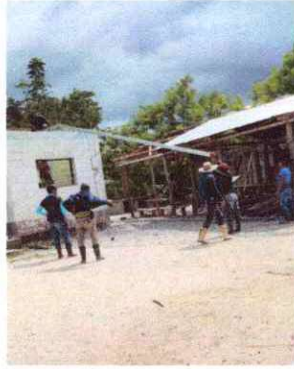
Foto 2: Cambio de estructura de soporte.
