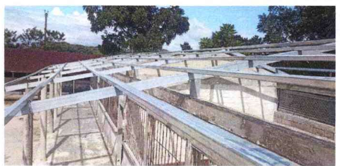
Foto 6: Cambio de estructura de soporte.
