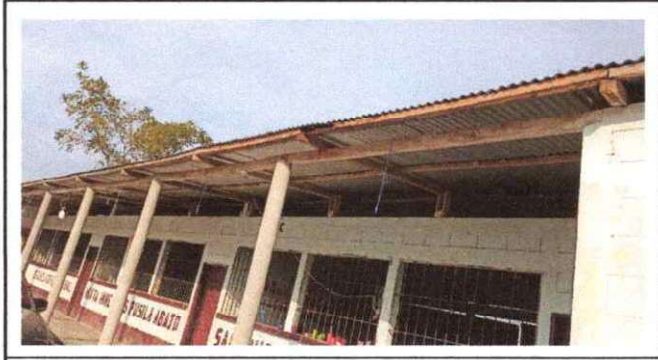
FOTO 1: CAMBIO DE LAMINA
