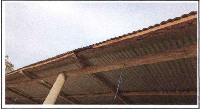
FOTO 2: CAMBIO DE ESTRUCTURA DE SOPORTE
