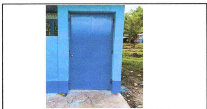
Foto 5: Sustitución de puerta
