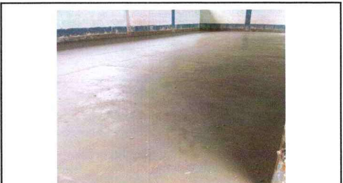
Foto 4: Reparación de planchas de concreto
