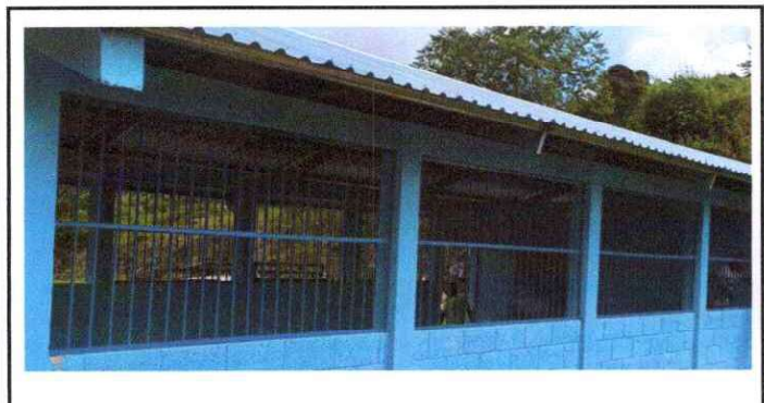
Foto 3: Fabricación e instalación de ventana-balcon de metal
