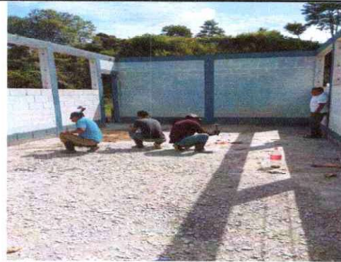
Foto 4: Reparación de planchas de concreto
