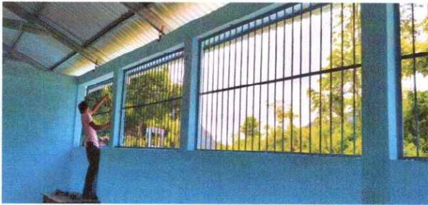
Foto 3: Fabricación e instalación de ventana-balcon de metal
