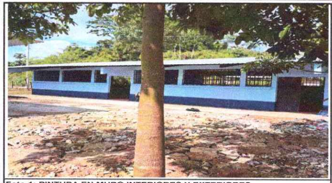
Foto 1: PINTURA EN MURO INTERIORES Y EXTERIORES.
