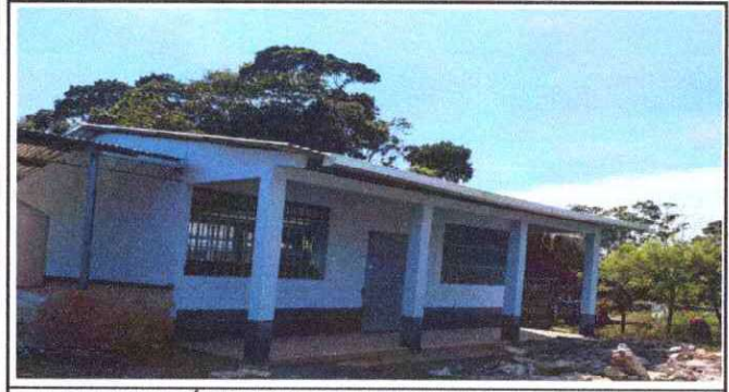
Foto 3: INSTALACIÓN DE BALCONES DE METAL.
