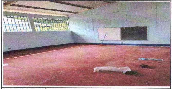
Foto 5: SUSTITUCIÓN DE PISO DE TORTA DE CONCRETO.
