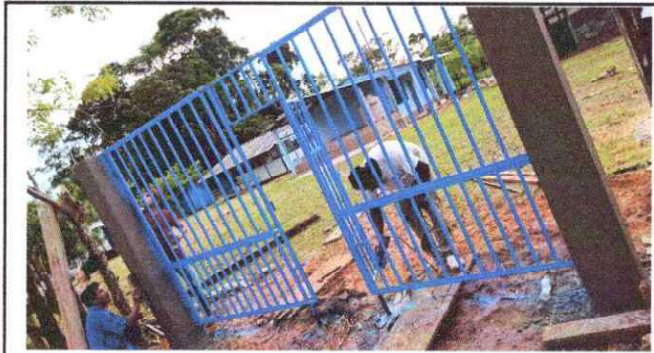
Foto 7: INSTALACIÓN DE PORTÓN.
