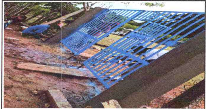
Foto 8: INSTALACIÓN DE PORTÓN.
