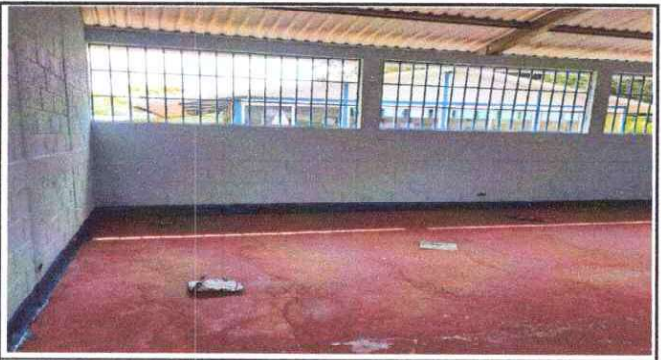
Foto 4: INSTALACIÓN DE BALCONES DE METAL.
