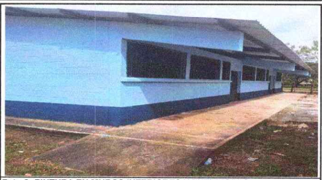
Foto 2: PINTURA EN MUROS INTERIORES Y EXTERIORES.
