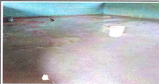
Foto 3: SUSTITUCIÓN DE PISO DE TORTA DE CONCRETO
