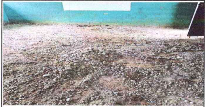
Foto 2: SUSTITUCIÓN DE PISO DE TORTA DE CONCRETO
