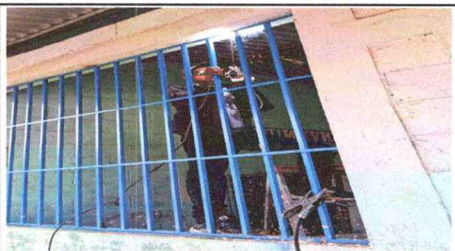
Foto 10: SUSTITUCIÓN DE BALCONES
