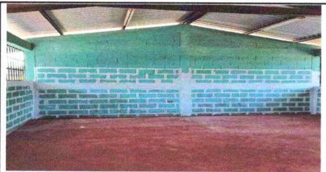
Foto 5: PINTURA EN MUROS INTERIORES Y EXTERIORES
