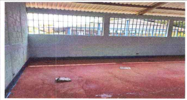
Foto 8: PINTURA EN MUROS INTERIORES Y EXTERIORES
