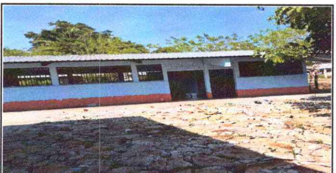
Foto 6: PINTURA EN MUROS INTERIORES Y EXTERIORES
