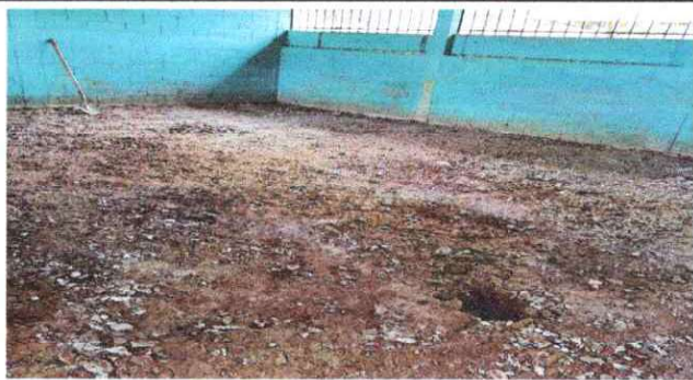
Foto 1: SUSTITUCIÓN DE PISO DE TORTA DE CONCRETO
