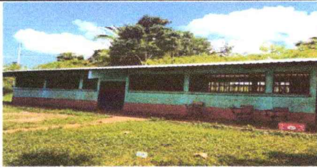
Foto1: Pintura en muros interiores y exteriores.
