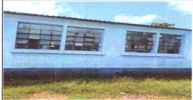
Foto 2: Sustitución de balcones.
