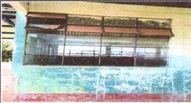
Foto 3: Sustitución de balcones de metal.
