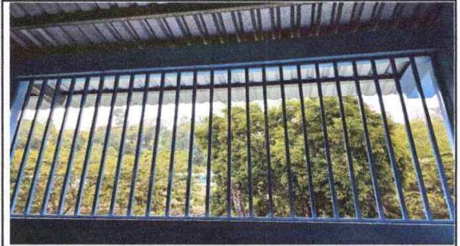
Foto 2: SUSTITUCIÓN DE BALCON DE HIERRO EN VENTANAS.
