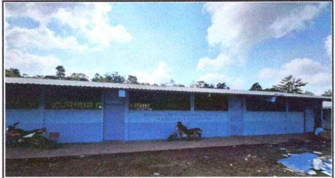
Foto 8: PINTURA EN MUROS INTERIORES Y EXTERIORES.
