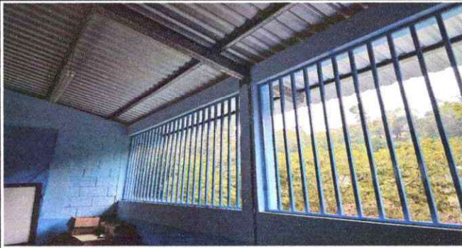
Foto 7: PINTURA EN MUROS INTERIORES Y EXTERIORES.
