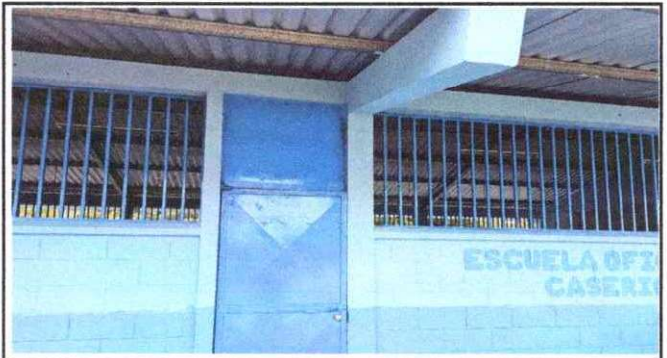
Foto 4: MANTENIMIENTO A ESTRUCTURA DE PUERTA.
