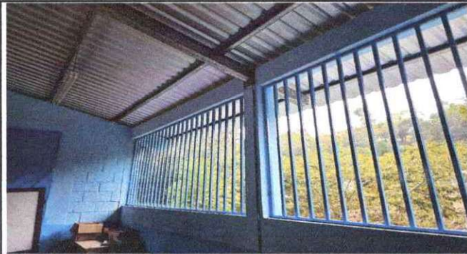
Foto1: SUSTITUCIÓN DE BALCONES DE HIERRO EN VENTANAS.
