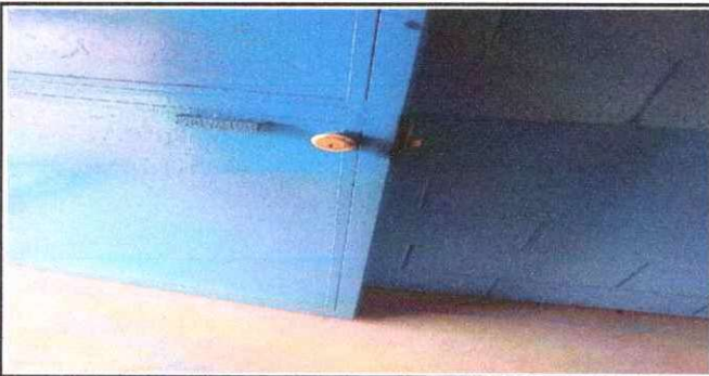
Foto 5: SUSTITUCIÓN DE CHAPA.
