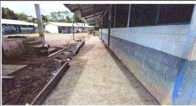
Foto 9: REPARACIÓN DE BANQUETAS DE CONCRETO.
