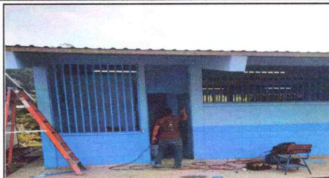
Foto 7: MANTENIMIENTO A ESTRUCTURA DE PUERTA DE METAL.
