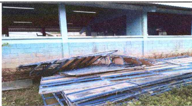
Foto 3: SUSTITUCIÓN DE BALCON DE HIERRO.
