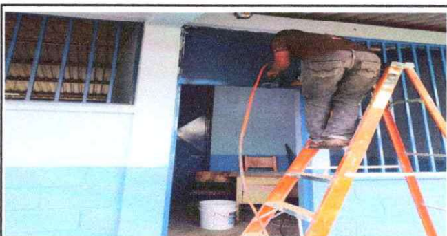
Foto 6: MANTENIMIENTO A ESTRUCTURA DE PUERTA DE METAL
