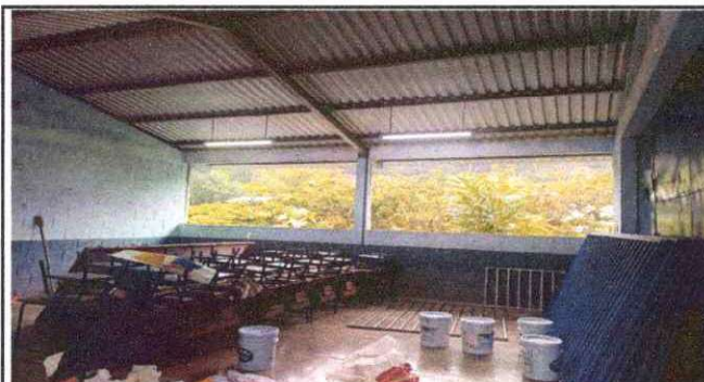
Foto 4: SUSTITUCIÓN DE BALCON DE HIERRO.
