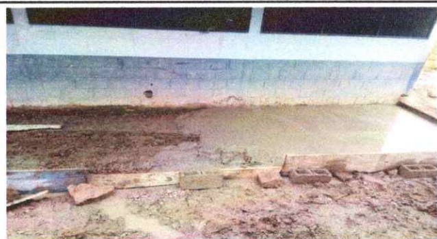
Foto 1: REPARACIÓN DE BANQUETA DE CONCRETO.
