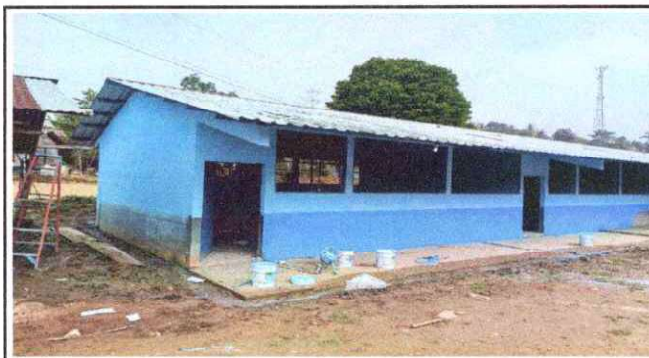
Foto 10: PINTURA EN MUROS INTERIORES Y EXTERIORES.
