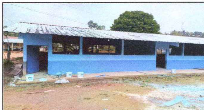
Foto 9: PINTURA EN MUROS INTERIORES Y EXTERIORES.
