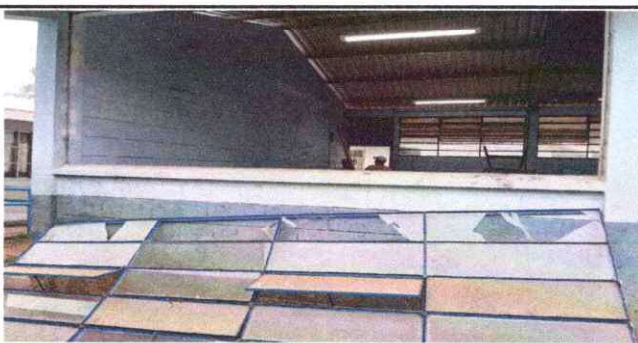
Foto 5: SUSTITUCIÓN DE BALCÓN DE HIERRO.
