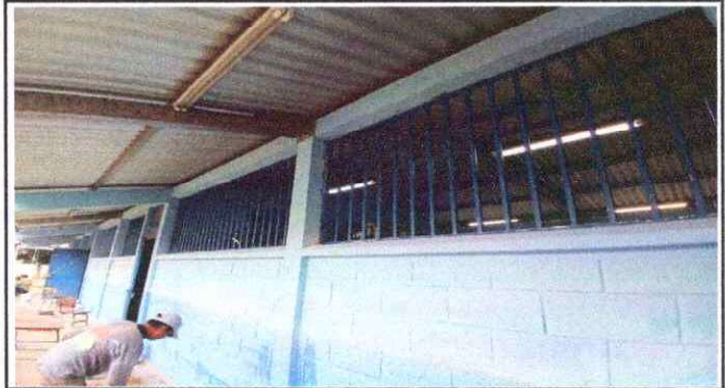
Foto 14: SUSTITUCIÓN DE LAMPARA TIPO LED
