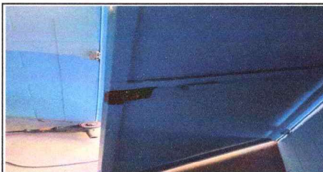
Foto 12: SUSTITUCIÓN DE CHAPA
