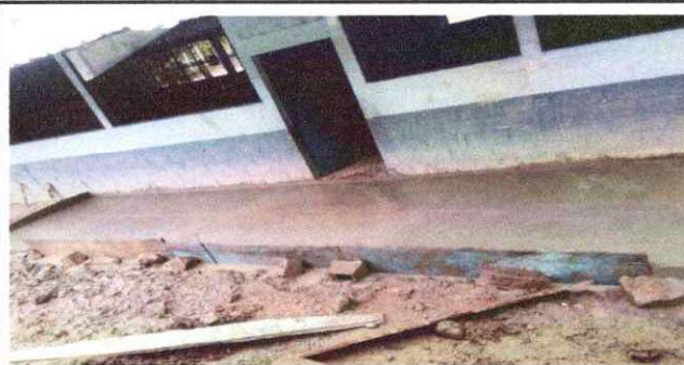
Foto 2: REPARACIÓN DE TORTA DE CONCRETO.
