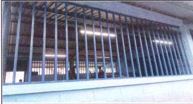
Foto 13: SUSTITUCIÓN DE LAMPARA TIPO LED
