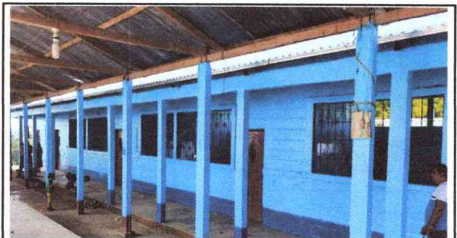
FOTO 6: Pintura en muros exteriores e interiores
