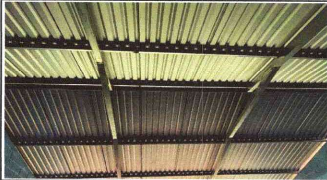
FOTO 1: Sustitucion de laminas, por laminas troquelada aluzinc calibre 26
