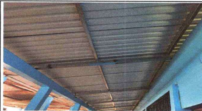
FOTO 3: Sustitucion de elementos de fijacion, Sustitucion de capote de lamina para lamina troquelada
