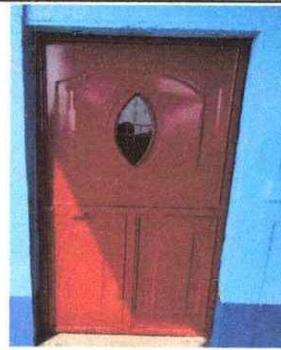
FOTO 4: Sustitucion de puertas
