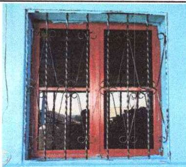
FOTO 5: sustitución de ventana de madera por metal mas vidrio
