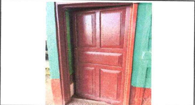
FOTO 4: Sustitucion de puertas
