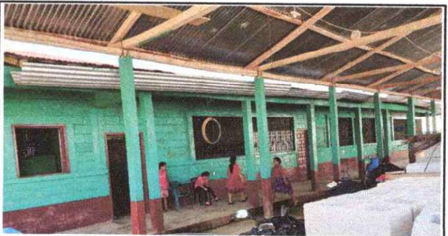
FOTO 6: Pintura en muros exteriores e interiores
