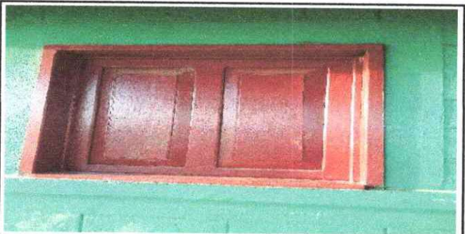
FOTO 5: sustitución de ventana de madera por metal mas vidrio
