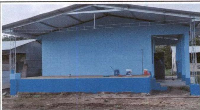
FOTO 3: SUSTITUCION DE ESTRUCTURA PORTANTE
