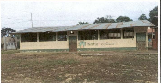
FOTO 4: SUSTITUCION DE PUERTAS DE METAL
