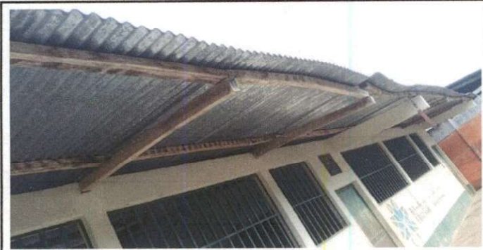
FOTO 3: SUSTITUCION DE ESTRUCTURA PORTANTE
