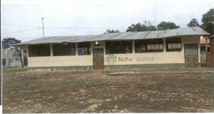
FOTO 1: SUSTITUCION DE TECHO
