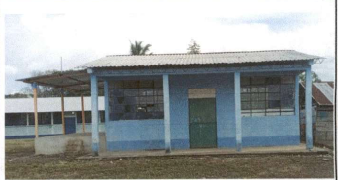
FOTO 2: SUSTITUCION DE TECHO
