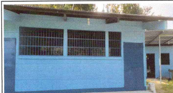
Foto 9: Sustitucion de Balcones de metal.
