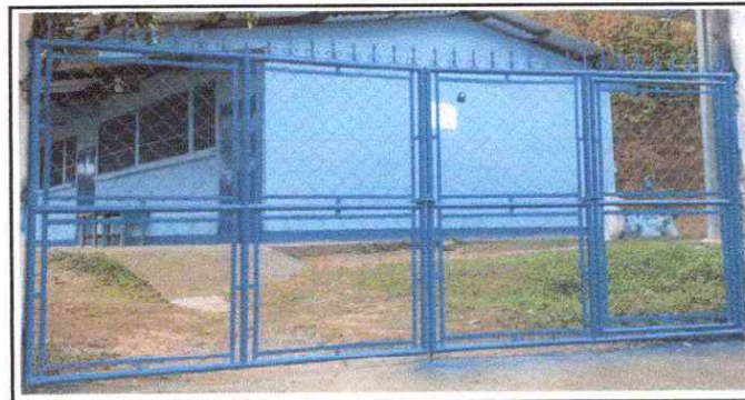
Foto 12: Mantenimiento a portón de metal
