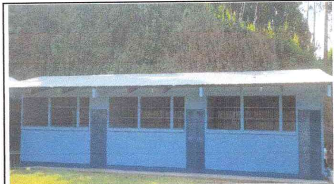
Foto 4: Mantenimiento a estructura de puertas de metal.
