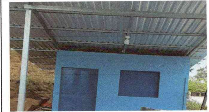
Foto 8: Sustitución de ventanas de madera por metal
