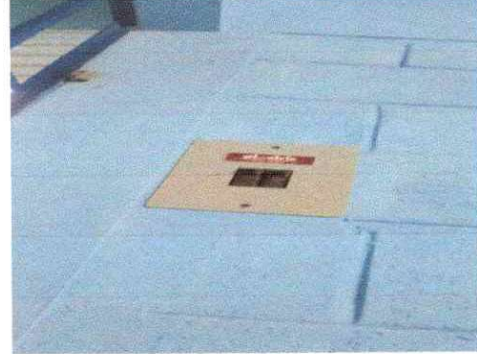
Foto 14: Reparacion de Cableado Eléctrico-
