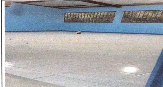
Foto 10: Sustitución de piso cerámico
