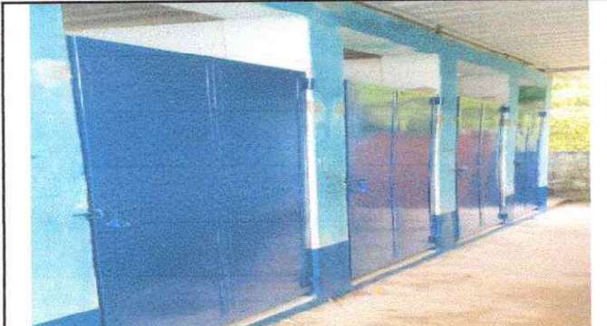
Foto 7: Sustitucion de puertas en servicio sanitario
