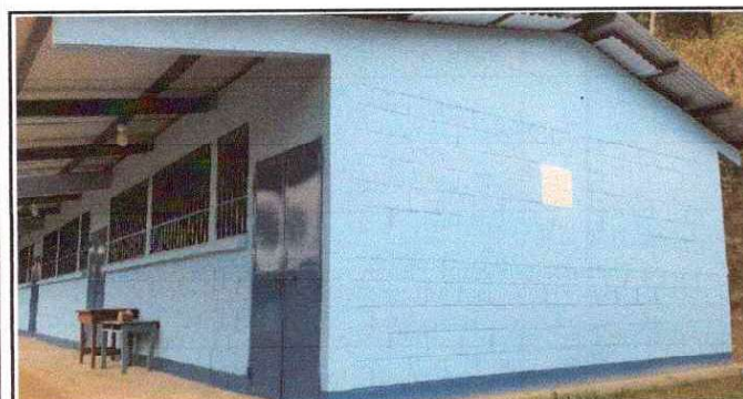
Foto 11: Pintura en muros exteriores e interiores
