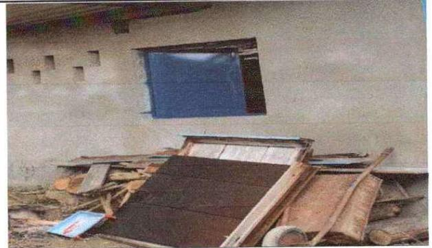
Foto 8: Sustitución de ventanas de madera por metal
