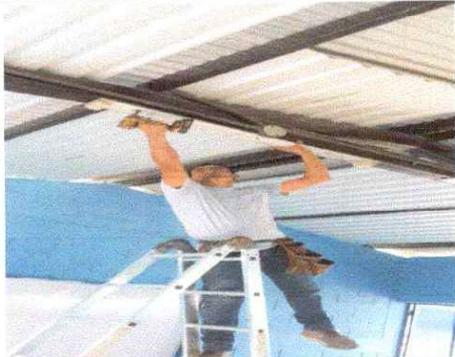
Foto 13: Sustitución de lámparas tipo led.
