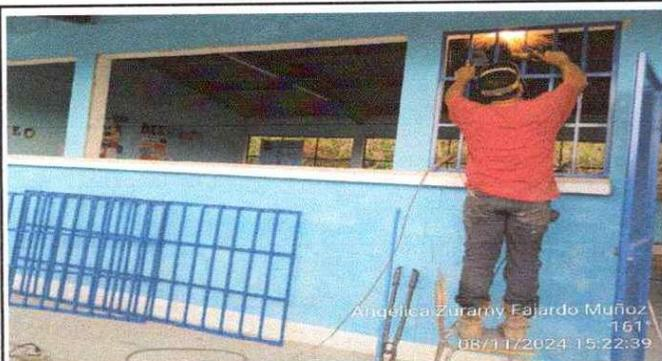
Foto 9: Sustitucion de Balcones de metal.
