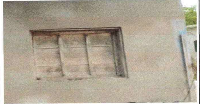
Foto 8: Sustitución de ventanas de madera por metal
