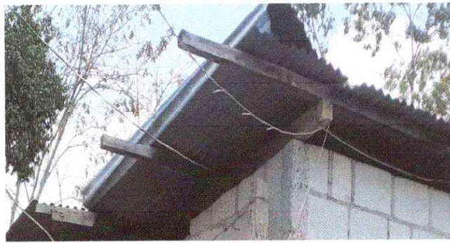
Foto 3: Sustitución de estructura de soporte de madera por metal.
