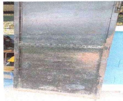
Foto 4: Mantenimiento a estructura de puertas de metal.
