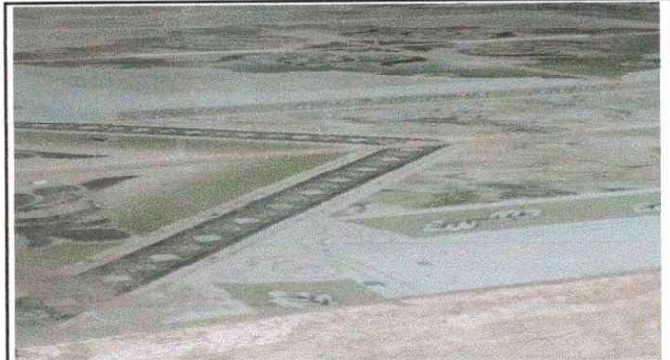
Foto 10: Sustitucion de piso cerámico
