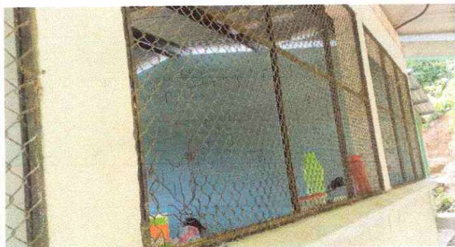
Foto 9: Sustitución de balcones de metal
