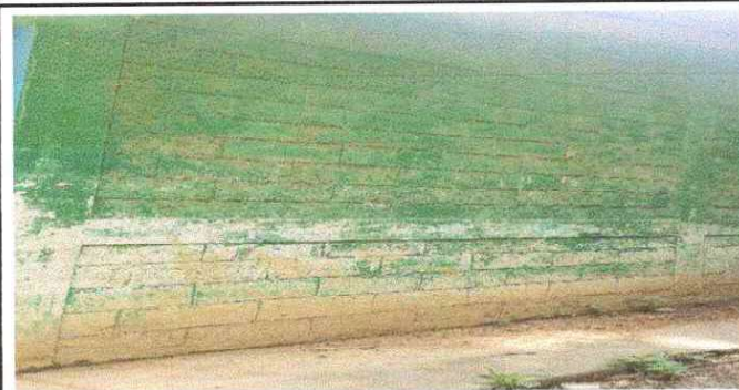
Foto 11: Pintura en muros exteriores e interiores.
