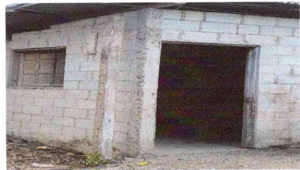
Foto 6: Sustitución de puertas.
