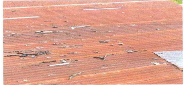
Foto 2: Sustitución de elementos de fijación.
