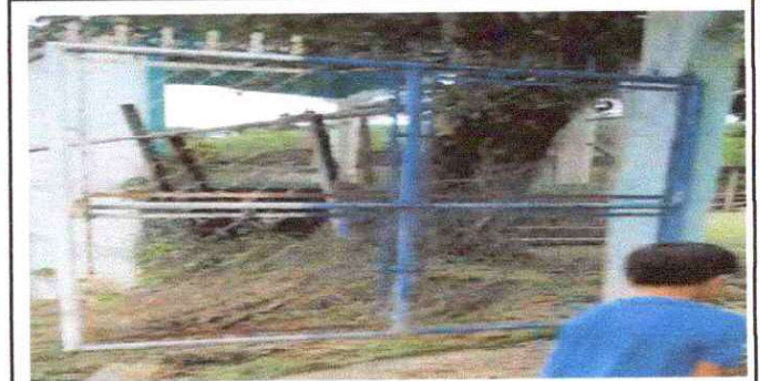
Foto 12: Mantenimiento a portón de metal.
