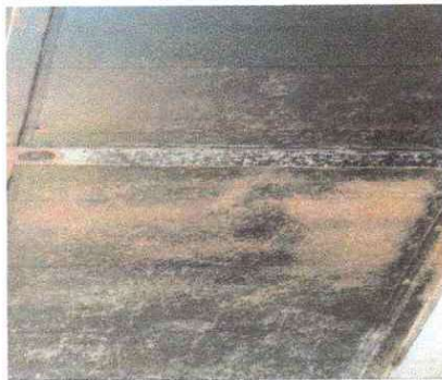
Foto 5: Sustitución de chapa.
