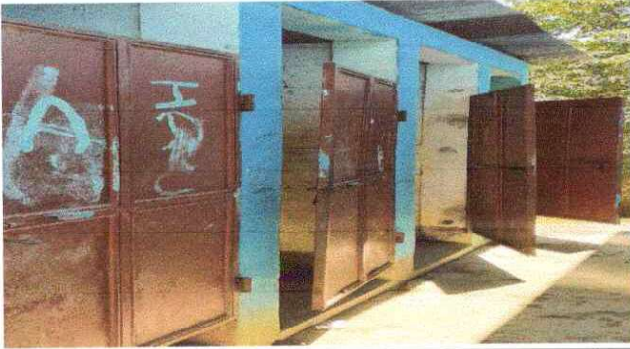
Foto 7: Sustitución de puertas en servicios sanitarios.
