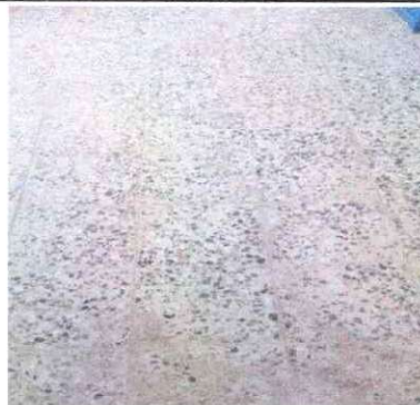
Foto 14: INSTALACION PISO DE GRANITO
