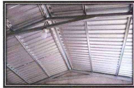
Foto 2: INSTALACION DE LAMINA TROQUELADA ALUCINZ CALIBRE 26
