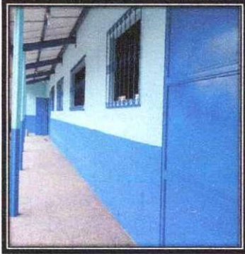
Foto 7: PINTURA EN EXTERIORES
