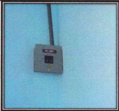
Foto 13: SUSTITUCIONDE TABLERO DE FLIPONES
