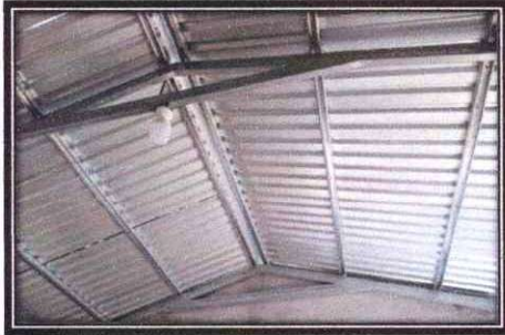
Foto 1 : INSTALACION DE ESTRUCTURA DE SOPORTE DE METAL
