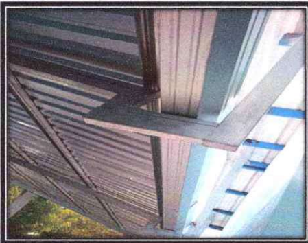
Foto 5: INSTALACION DE CANAL
