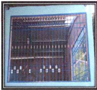
Foto 3: INSTALACION DE BALCON
