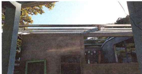
FOTO 1. INSTALACION DE ESTRUCTURA DE SOPORTE DE METAL
