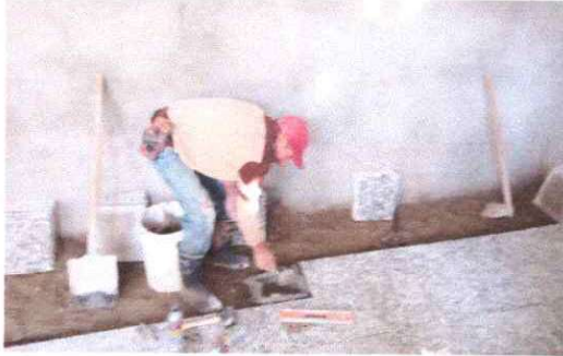
FOTO 7. SUSTITUCION DE PISO DE GRANITO
