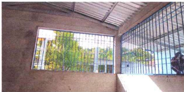
FOTO 3. INSTALACION DE BALCON
