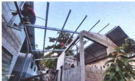
FOTO 2. INSTALACION DE LAMINA TROQUELADA ALUCINC CALIBRE 26
