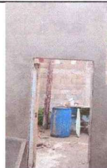
FOTO 4. SUSTITUCION DE PUERTA
