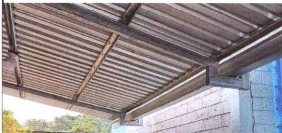
FOTO 5. INSTALACION DE CANAL
