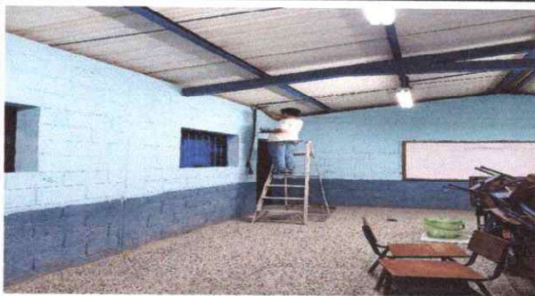
FOTO 9. PINTURA EXTERIOR E INTERIOR
