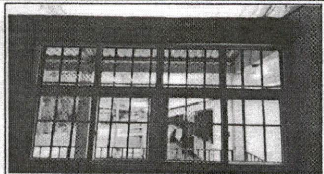
Foto 2: INSTALACION DE VENTANA PVC Y BALCONES
