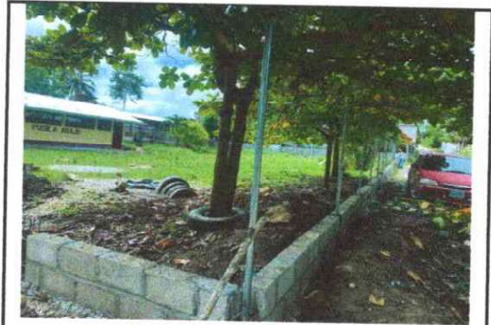
Foto 13: REPARACION DE TUBO HG Y MALLA GALVANIZADA
