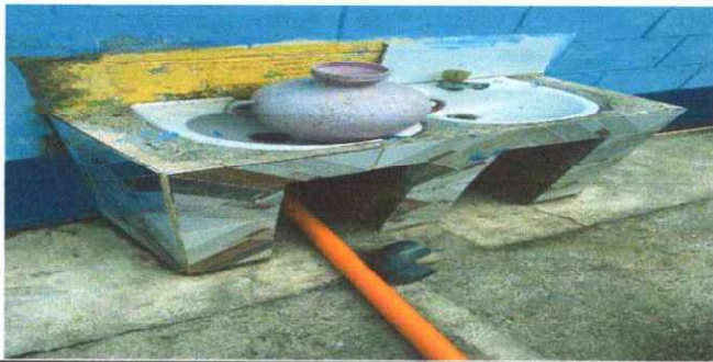
Foto 9:SUSTITUCION DE TUBERIA PVC LINA PRINCIPAL AGUAS NEGRAS
