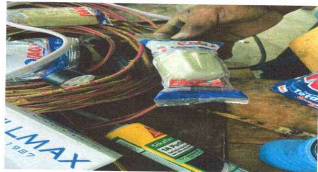
Foto 4: SUSTITUCION DE INTERRUPTORES SIMPLES
