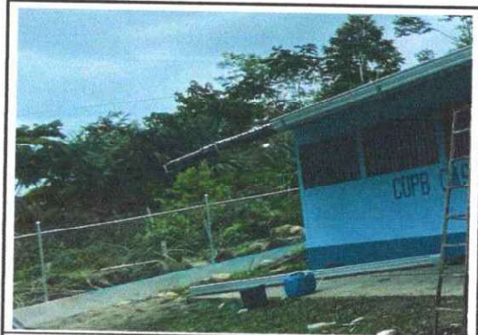
Foto 15: SUSTITUCION DE SOPORTE O PESCANTE DE METAL PARA CANAL
