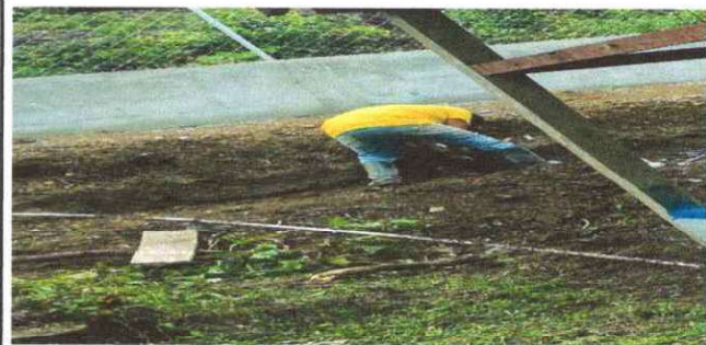
Foto 8:SUSTITUCION TUBERIA LINEAL PRINCIPAL
