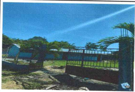
Foto 12: MANTENIMIENTO DE PORTON DE METAL
