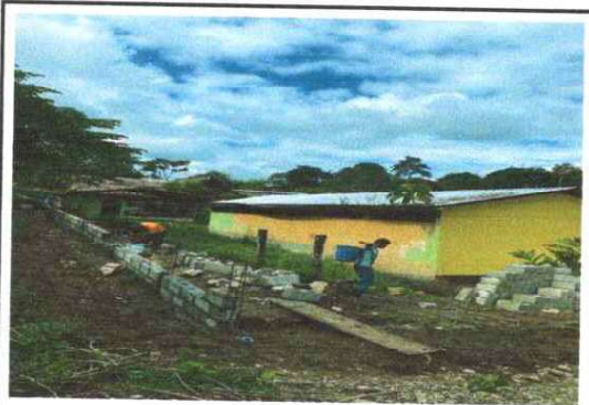
Foto 14: MANTENIMIENTO DE MURO PERIMETRAL DE BLOCK
