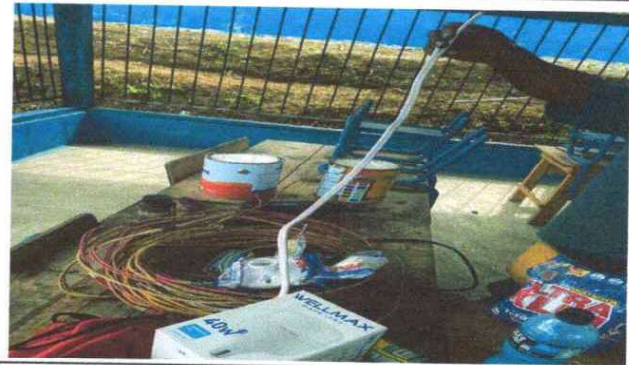
Foto 2: REPARACION DE CABLEADO ELECTRICO
