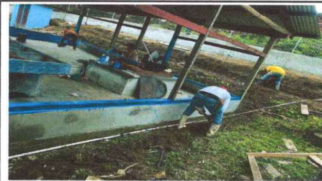
Foto 10:INSTALACION DE TUBERIA PRINCIPAL DE PVC
