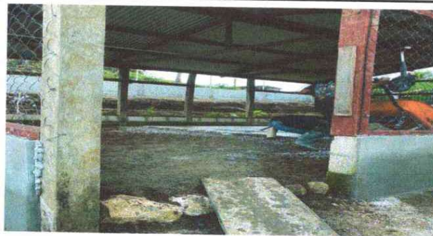
Foto 6: SUSTITUCION DE PISO DE TORTA DE CONCRETO
