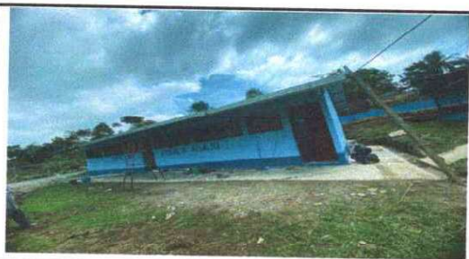
Foto 16: SUSTITUCION DE CANAL DE METAL
