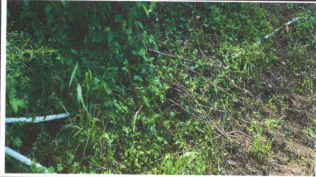
Foto 10:INSTALACION DE TUBERIA PRINCIPAL DE PVC
