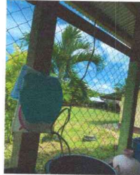
Foto 2: REPARACION DE CABLEADO ELECTRICO
