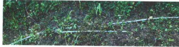
Foto 8:SUSTITUCION TUBERIA LINEAL PRINCIPAL
