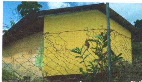
Foto 13: REPARACION DE TUBO HG Y MALLA GALVANIZADA
