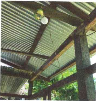
Foto 3: SUSTITUCION DE PLAFONERA
