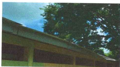
Foto 16: SUSTITUCION DE CANAL DE METAL
