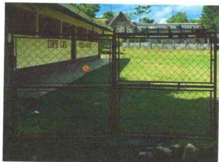
Foto 12: MANTENIMIENTO DE PORTON DE METAL
