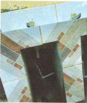
Foto 9:SUSTITUCION DE TUBERIA PVC LINA PRINCIPAL AGUAS NEGRAS
