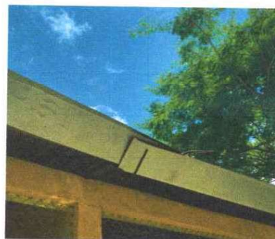
Foto 15: SUSTITUCION DE SOPORTE O PESCANTE DE METAL PARA CANAL
