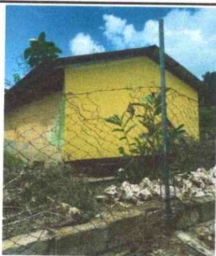
Foto 14: MANTENIMIENTO DE MURO PERIMETRAL DE BLOCK
