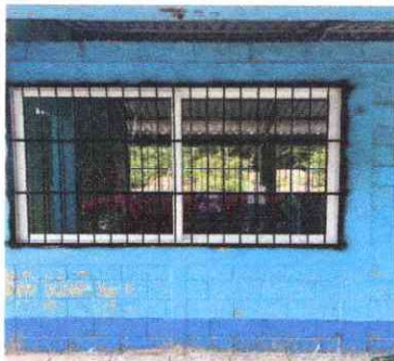
Foto 5: Sustitución de estructura de metal de ventana
