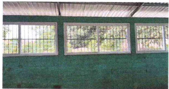
Foto 6: Sustitución de vidrios
