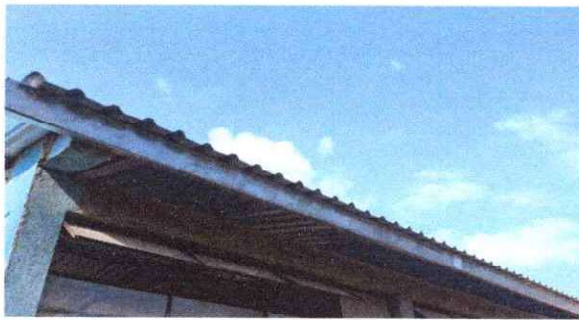
Foto 3: Sustitución de lamina, por lámina troquelada aluzin calibre 26.
