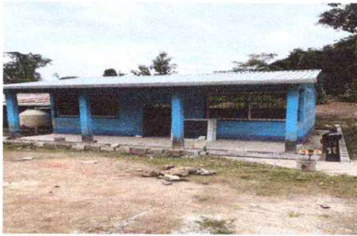
Foto1: Sustitución de lamina, por lámina troquelada aluzin calibre 26.
