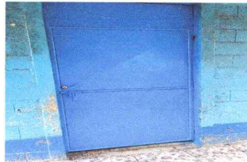
Foto 4: sustitución de puerta
