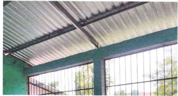
Foto 2: Sustitucion de estructura de soporte de metal por metal.
