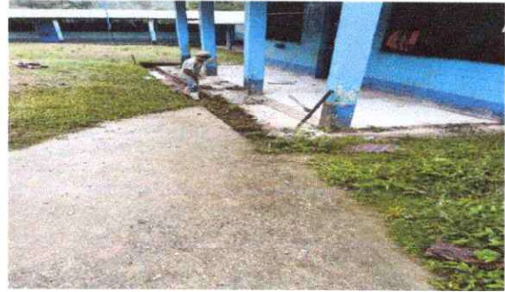
Foto 2: reparacion de cuneta de concreto
