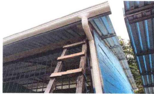
Foto 4: sustitución de canal de metal.
