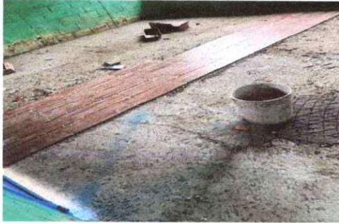
Foto 2: Sustitucion de piso de cemento liquido.
