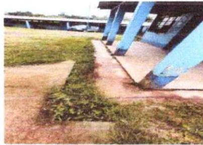
Foto 8: Reparación de cuneta de concreto
