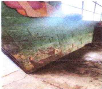
Foto 9: pintura en muros exteriores e interiores
