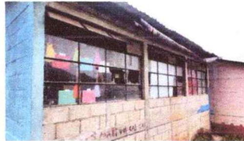
Foto 10: Sustitución de canal de metal
